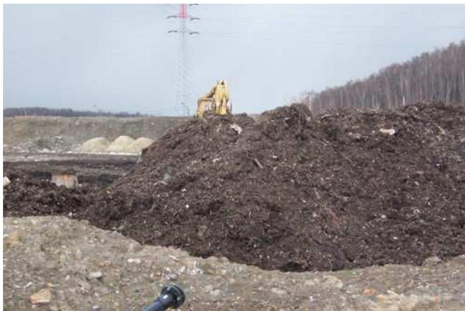
**Figure 8 : Tas de compost en attente d'être déposé sur les déchets**
