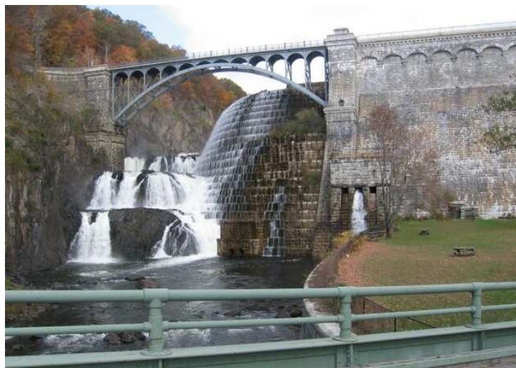
Figure 3 : barrage de New Croton aux États-Unis (1906) – (Wikipedia, 2012).
