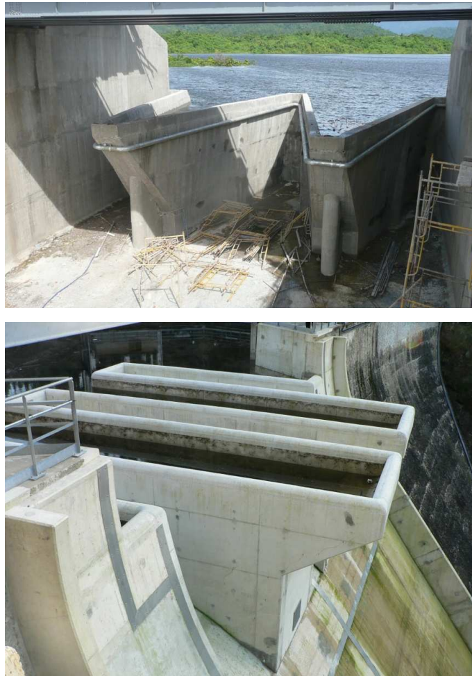
Figure 11 : photo supérieure : déversoir en labyrinthe du barrage de Song Mong (Vitenam) & photo inférieure : déversoir en touches de piano du barrage de l'Etrouit (France) – (banque de photos du HECE).
