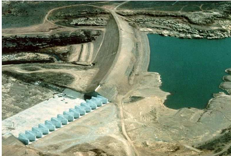
Figure 12 : barrage de l'Ute au Nouveau-Mexique aux Etats-Unis (déversoir en labyrinthe) - (Bureau of Reclamation, 2010).
