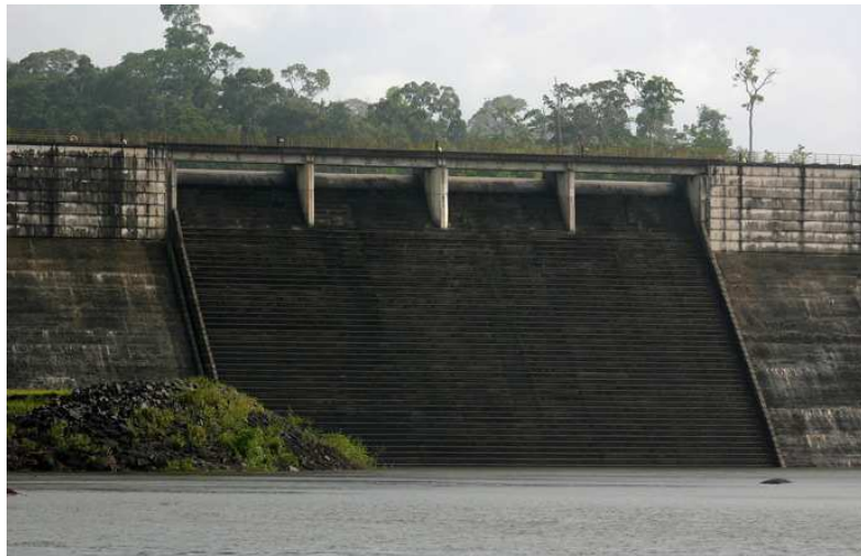
Figure 10 : barrage de Petit-Saut sur le fleuve Sinnamary (Guyane française), combinant un déversoir libre standard et un coursier en marches d'escalier – ( site : http://webtice.ac-guyane.fr ).
