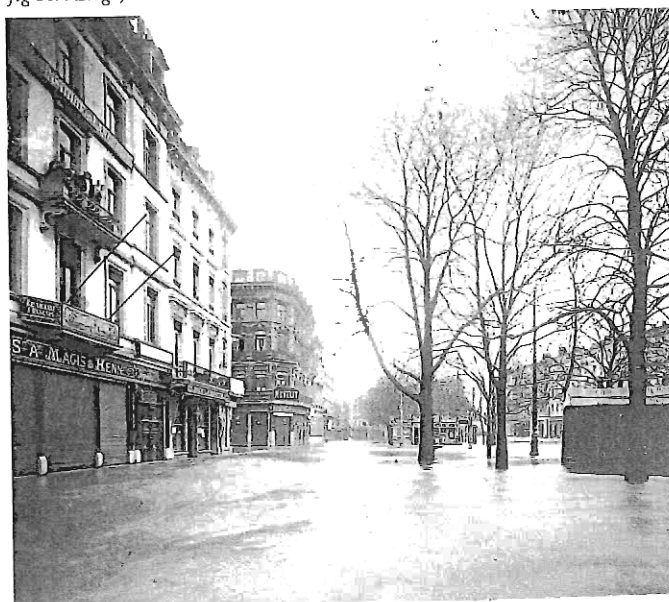
fig 167. Liège, inondations de 1926.
