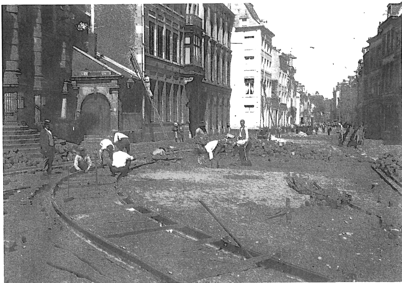
Pose des rails du tramway en Hors-Château, vers 1895. M.V.W.
