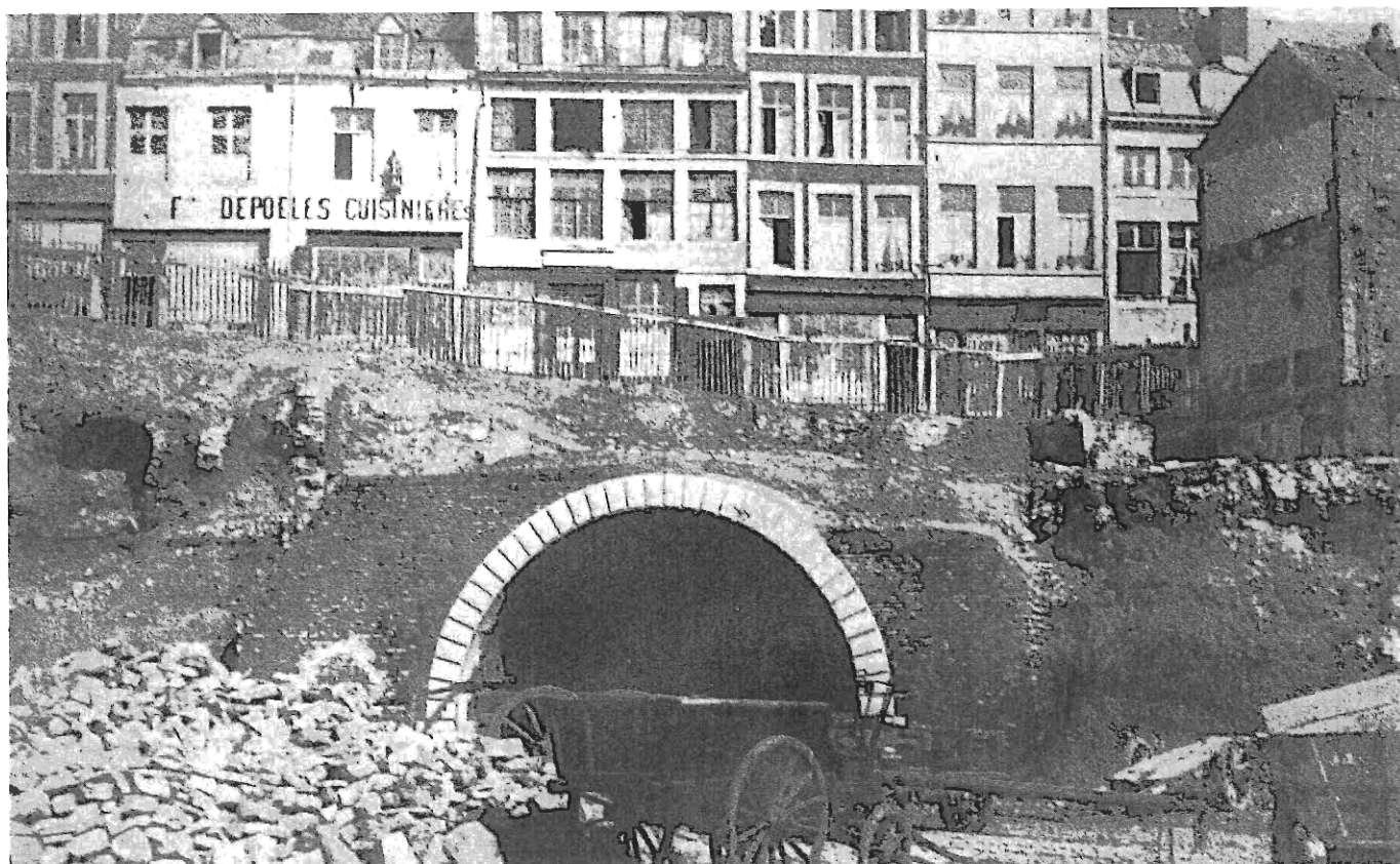
Construction du tunnel du chemin de fer sous Pierreuse, en 1873. Coll. Art. U.Lg.
