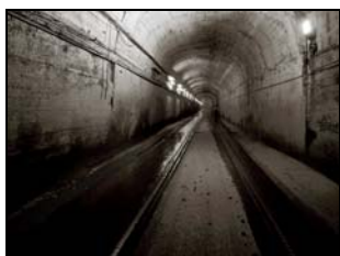
Fig 161 – Un exemple d'un espace terne.
