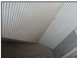
Fig 67 – Le plafond traduisant la complexité de la toiture. [Institut Montéfiore, Jean Maquet, photo de l'auteur, 2008]
