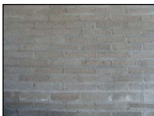
Fig 137 – Mur en béton : symbole de stabilité.
