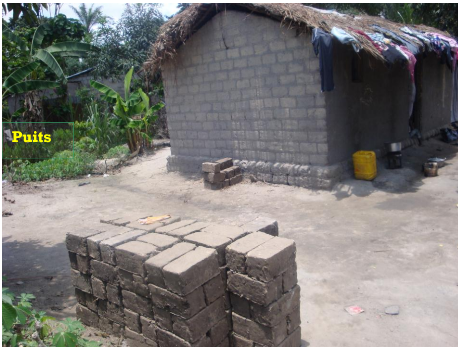
Fig. 31: Une maisonnette de Lemba Imbu à base des matériaux d'un puits environnant
