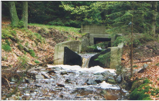
Fig. 1. Exutoire du bassin versant de la Robinette aménagé avec un déversoir en V. Ce dispositif est adapté pour la mesure du débit des ruisseaux à régime torrentiel
