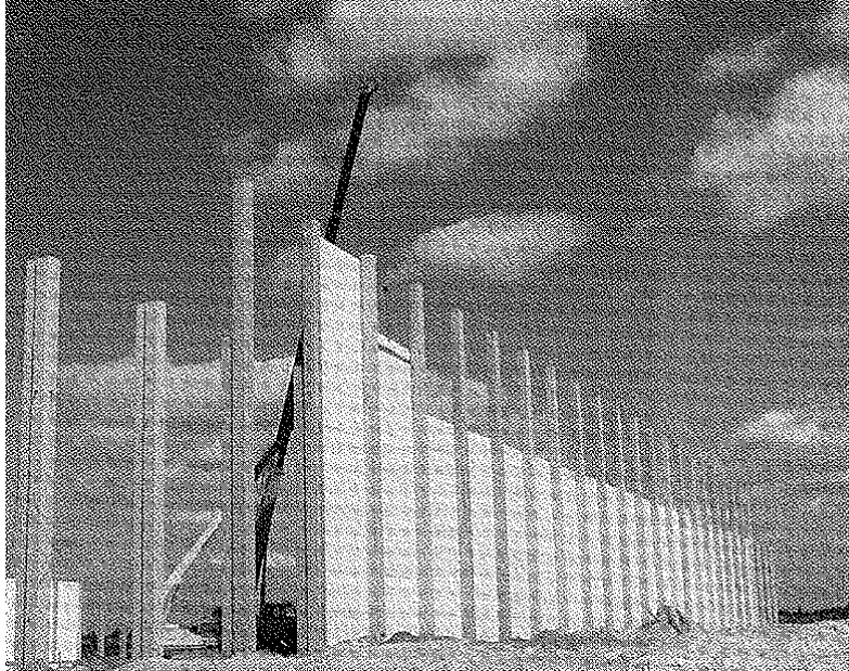
Hall industriel en dalles de béton cellulaire et colonnes en acier
