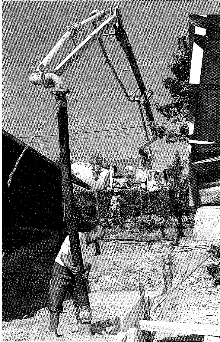
Coulage d'une dalle
