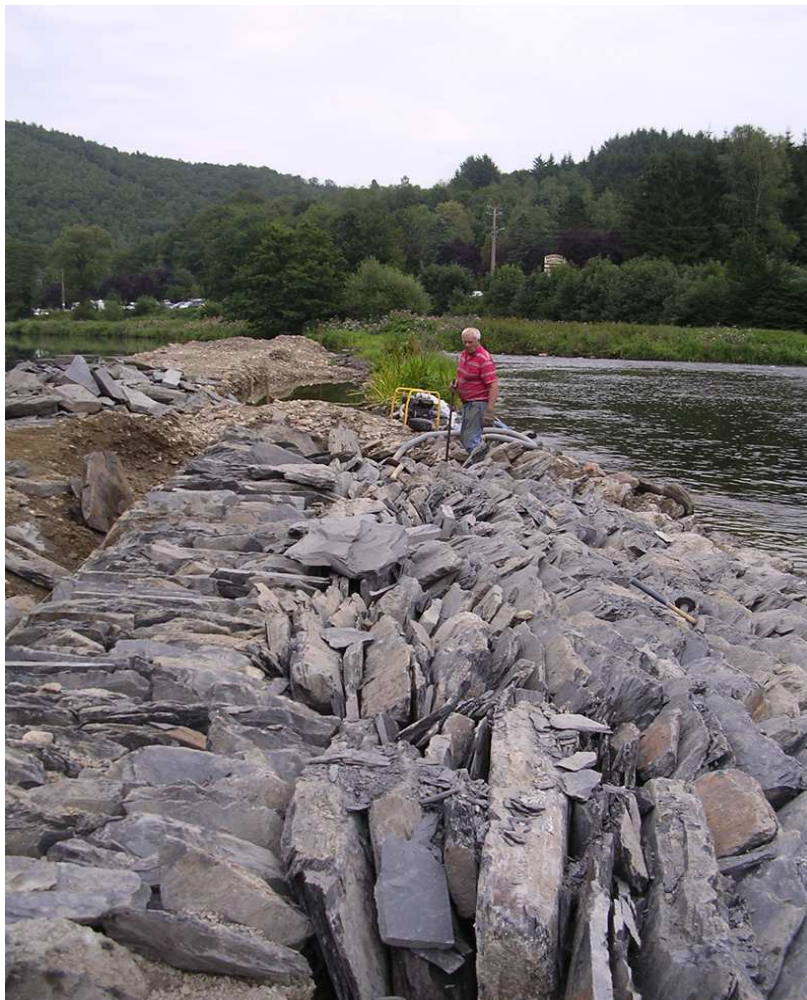
Figure 8. Chantier de restauration du barrage de Alle-sur-Semois (photo F. Rosillon, 2006)
