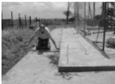
Fig. 9: Mesure de la tension de pas sur le site de Makola
