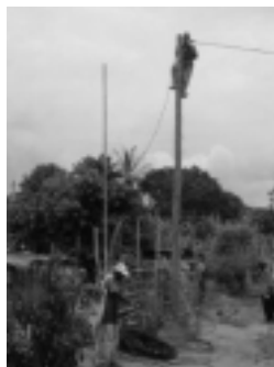
Fig. 11: Le réseau BT lors des travaux
