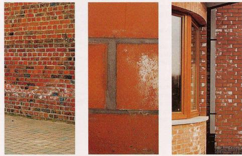
*Efflorescence due à des sels contenus dans le sol ou dans la terre cuite (source Febelcem)*
