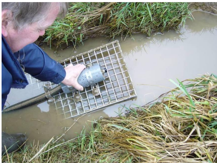
FIGURE 5. SONDE DE HAUTEUR D'EAU INSTALLEE DANS LE COURS D'EAU DU BASSIN PILOTE
