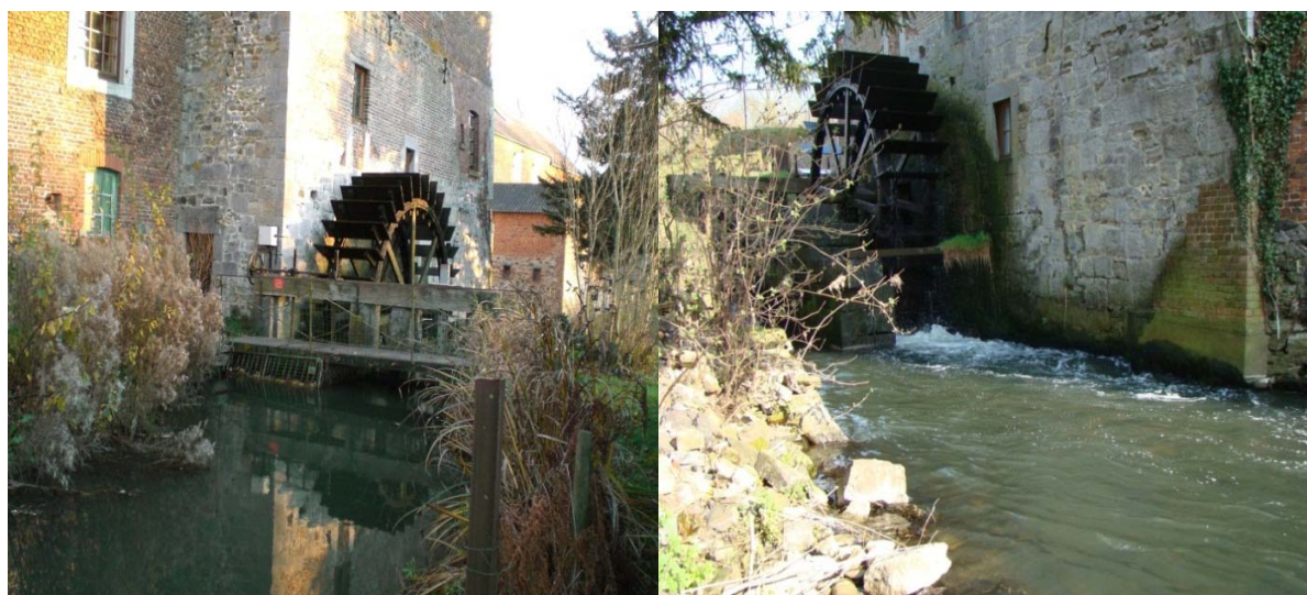
Figure 3 : Vue de l'amont (à gauche) et vue de l'aval (à droite) de la roue du Moulin à eau de Fallais.
