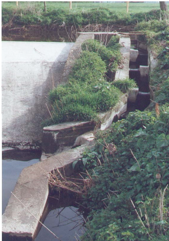
Photo 4: Barrage de Mouland (2,3 km de l'embouchure ; n° 1 sur la fig. 6) en Région flamande avant sa destruction en 1998 (photos MRW-FSPESB, 1997). (Dessus) Vue d'ensemble de l'ouvrage en période de bas débit montrant le seuil en béton et l'écoulement perché du faible débit naturel par un pertuis cylindrique situé dans le bief d'alimentation de l'ancien moulin; (Dessous) Echelle à poissons à bassins considérée comme peu fonctionnelle, notamment à cause du manque d'eau.
