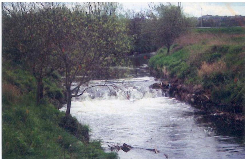
Photos 24: Trois petits seuils en gabions et enrochements construits pour tenter de stabiliser le lit de la basse Berwinne dans son parcours en Région flamande.
