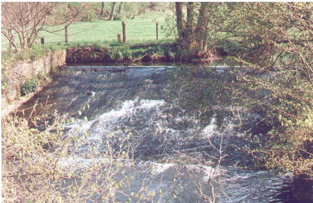
Photo 9: Barrage de Val-Dieu sur la Berwinne de 2ème cat.
