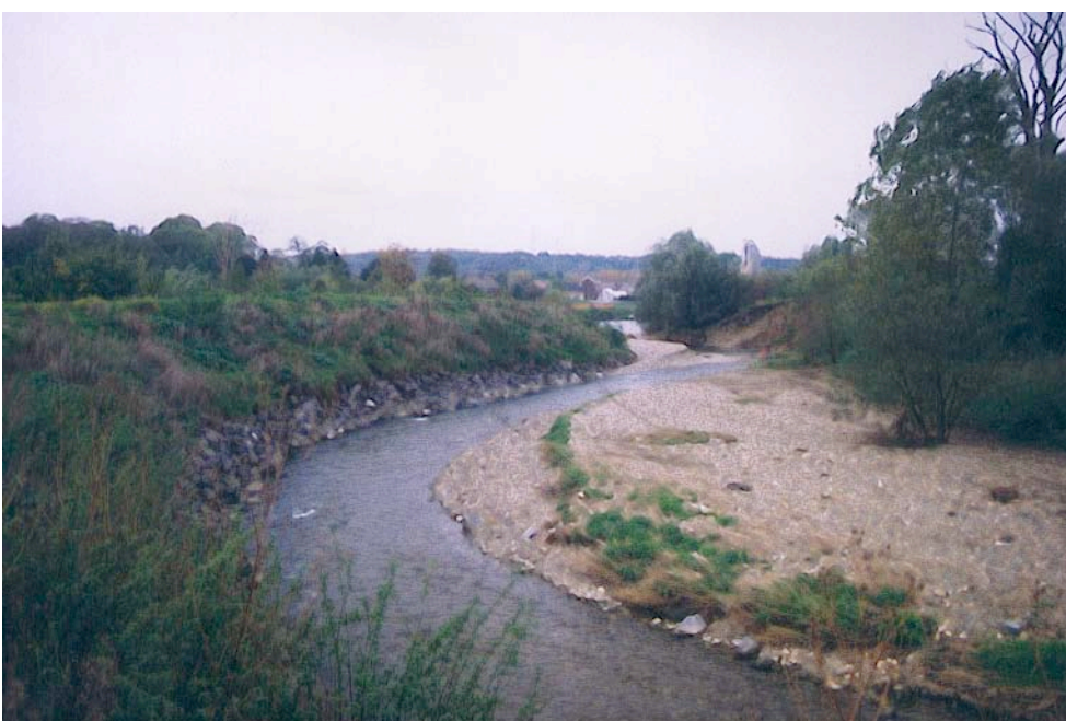
Photos 20: Embouchure naturelle de la Berwinne dans la basse Meuse. La photo du bas montre le tronçon d'une centaine de mètres de la basse Berwinne qui est restée en Région wallonne après la déviation du cours lors de la construction du barrage de Lixhe.
