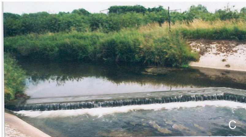
Photos 27: Vue des parties amont (A) et aval (B, C) de l'aménagement du passage de la Berwinne sous la bretelle de sortie vers Mouland de l'autoroute E25. Le chenal latéral d'étiage étant obstrué par des dépôts de sédiments, les faibles débits s'écoulent en lame mince sur le muret de guidage de l'eau, ce qui constitue un obstacle de Dh = 0,5 m infranchissable dans ces conditions par certains poissons.
