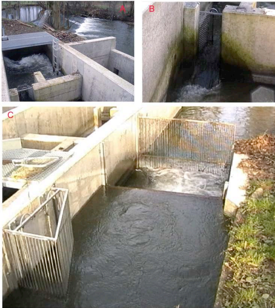
Photo 10: Vue de l'échelle à poissons du barrage de Berneau montrant (A) la disposition des bassins et le dispositif de piégeage des poissons dans le bassin supérieur ; (B) le cone de piégeage et (C) la prise d'eau à l'amont protégée par une grille amovible ainsi que la grille contrôlant l'entrée du bief d'alimentation d'un étang de pêche.
