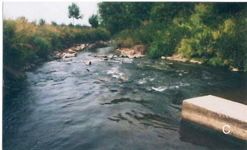
Photos 26: Vues vers l'amont (A) et vers l'aval (B, C) de l'aménagement du passage de la Berwinne sous l'autoroute E25. L'ouvrage de concentration du débit fonctionne correctement et l'écoulement dans la partie aval de l'ouvrage ne forme pas une chute-obstacle à l'étiage.
