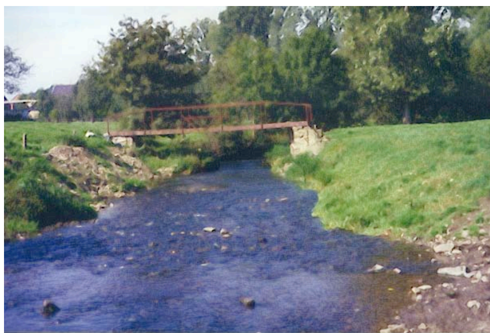
Photos 2 A: Vues actuelles de la Berwinne à Neufchâteau (dessus) et Mortroux (dessous).
