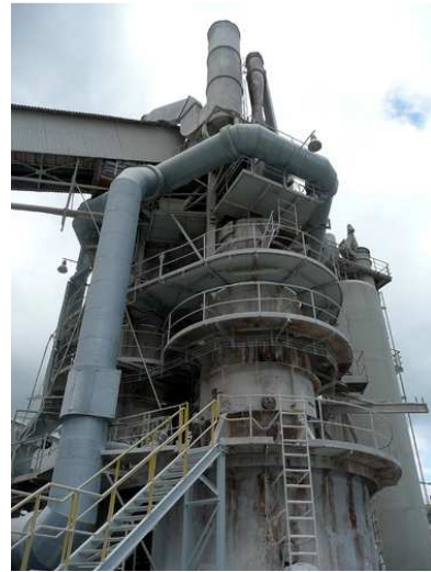
Four à chaux sur le site de Moha (photo T. Japin, 2008)
