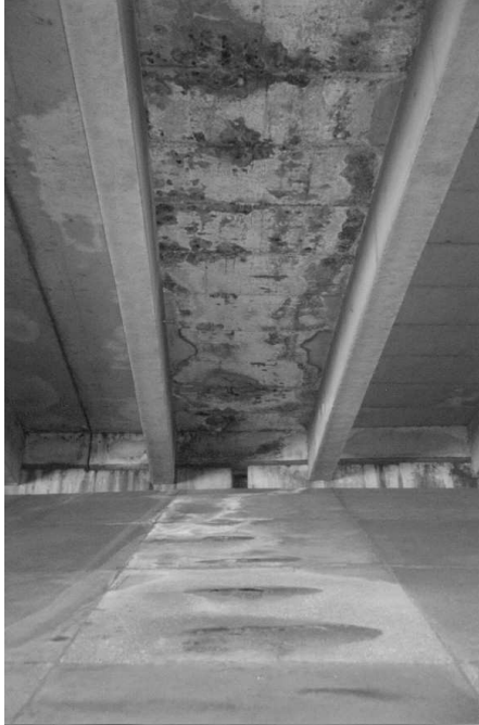
Vue macroscopique de la face inférieure d'un tablier de pont
