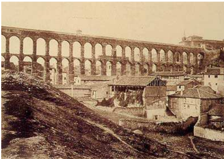
Figure IV-1 : aqueduc de Segovie (ciment romain)
