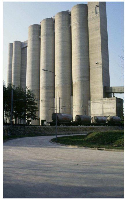
Figure IV-9 : entreposage du ciment dans les silos
