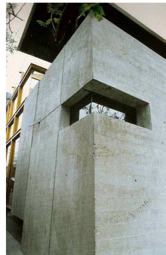
Figure IV-2 : utilisation de ciments modernes pour la fabrication de bétons apparents
