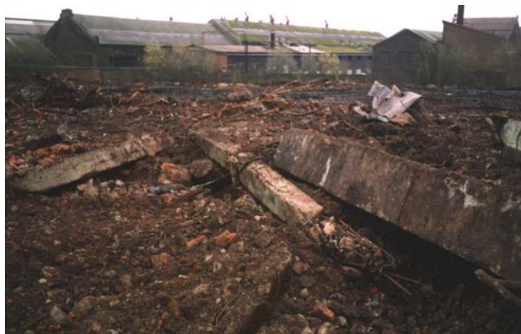
Le site durant les travaux d'assainissement
