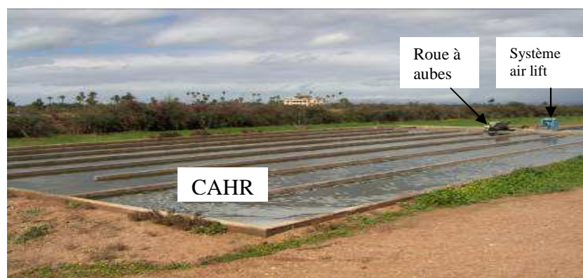
Figure VI-3 : Le Chenal Algal à Haut Rendement de Marrakech avec ses deux systèmes d'agitation (roue à aubes ou air lift)
