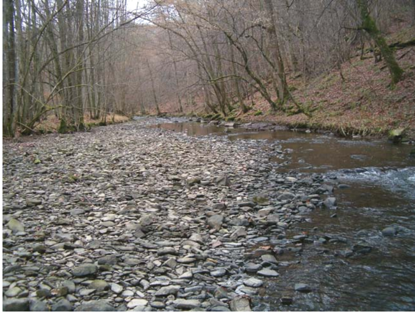
Photo 4 : Mise à sec du cours principal de la Lhomme en amont de la centrale Hydroval
