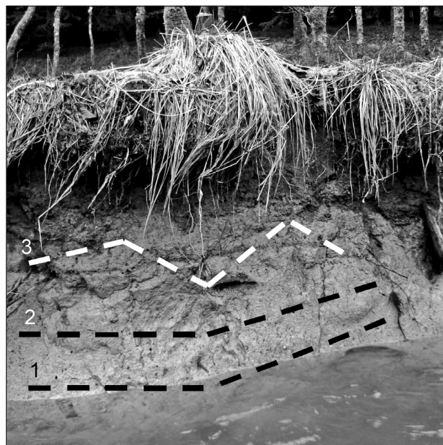
Fig 7 – Evolution d'une encoche dans une berge de la Chavanne durant la montée des eaux après la période de gel (date de la prise de vue : 22/02/09). La berge a été rafraîchie par une crue supérieure à Q_b le 17/02/09. 1 : encoche le 18/01/09 ; 2 : encoche le 20/01/09 ; 3 : encoche le 24/01/09.
