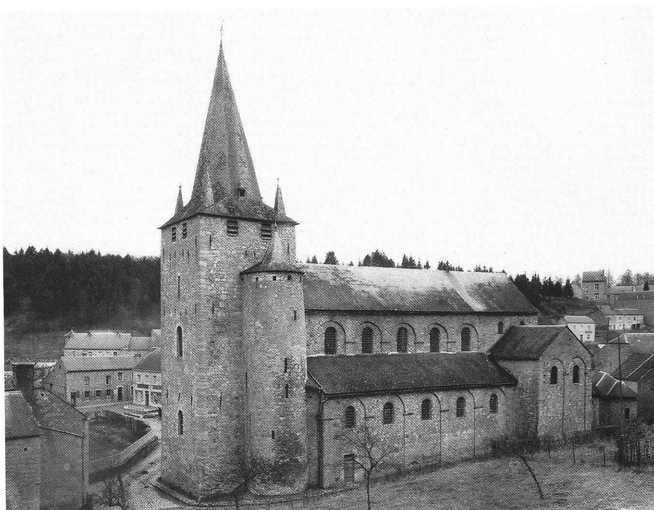
Eglise Saint-Hadelin à Celles. Eglise mosane type (début XI e siècle), avec avant-corps trinaire et crypte.
