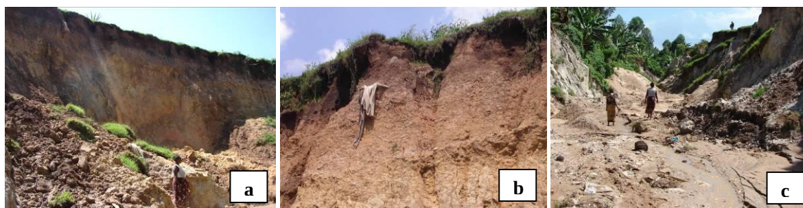
Figure 7.6. Glissement des terrains le long des ravins de Kisingiri. a) Glissement important en aval de l'ancien cimetière de Kisingiri ; b) des vieux tombeaux interceptant de l'eau et prédisposant au glissement ; c) glissement et élargissement du ravin.
