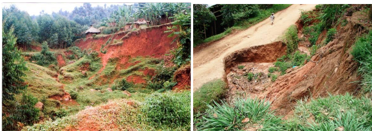
Figure 4.14. Ravines collinaires liées au ruissellement torrentiel. a). Colline de Ngere ; b). Axe routier Abattoir-Katsya à la latitude de Kasongomi.
