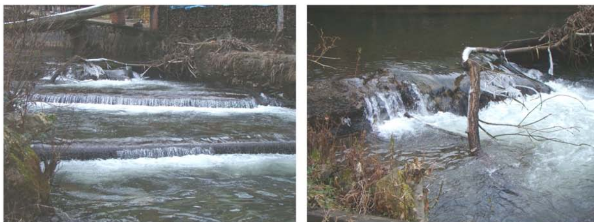
Planche photo 10: Vue d'un obstacle physique dans la Lienne au lieu-dit « les Forges ».
