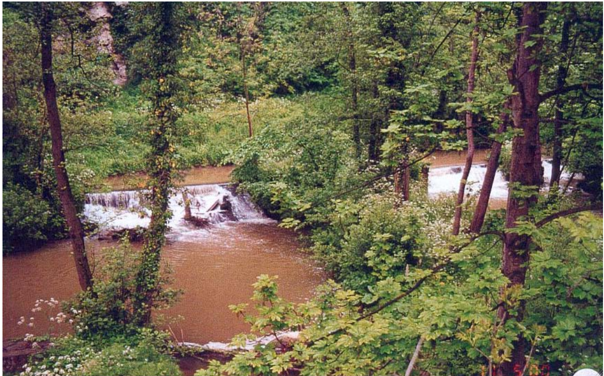
Photo 3: Vue du barrage du Four à Chaux Carmeuse à Moha que doivent impérativement franchir les anguilles du lot 4 pour se diriger vers l'échelle à poissons de Huccprgne.
