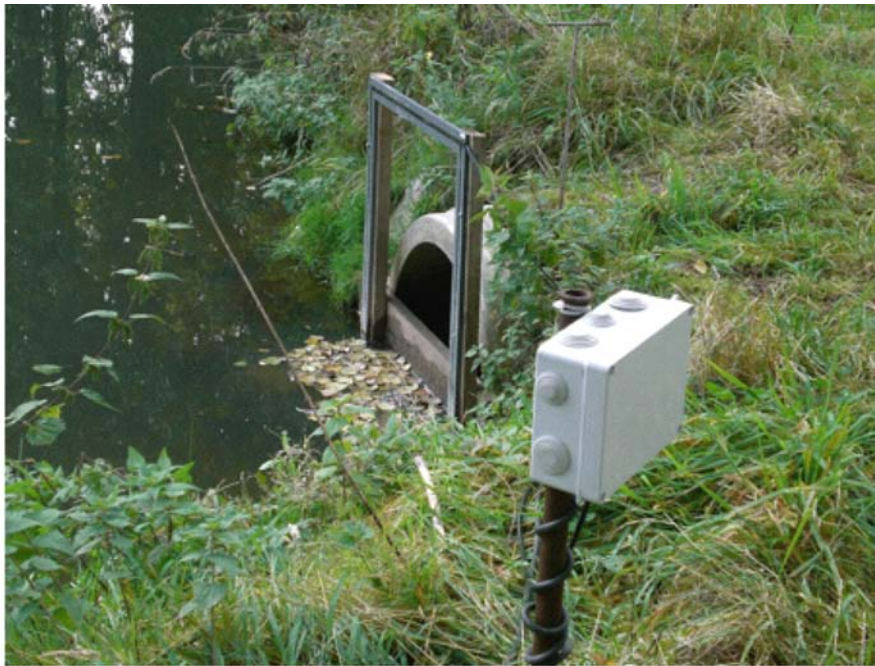
Photo 1: Vue de l'antenne de détection CIPAM placée à la sortie de la passe à poissons de Huccorgne.
