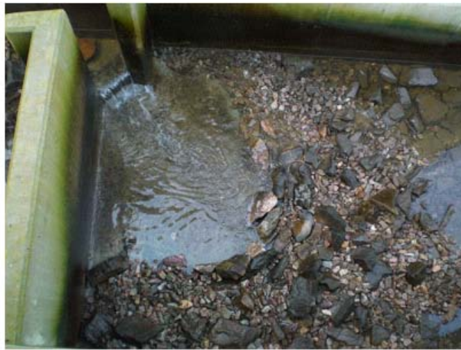
Planche photo 11 : Evolution de la répartition du substrat de fond dans les bassins de l'échelle à poissons de Lorcé entre octobre 2007 (mise sous eau) et fin novembre 2008.
