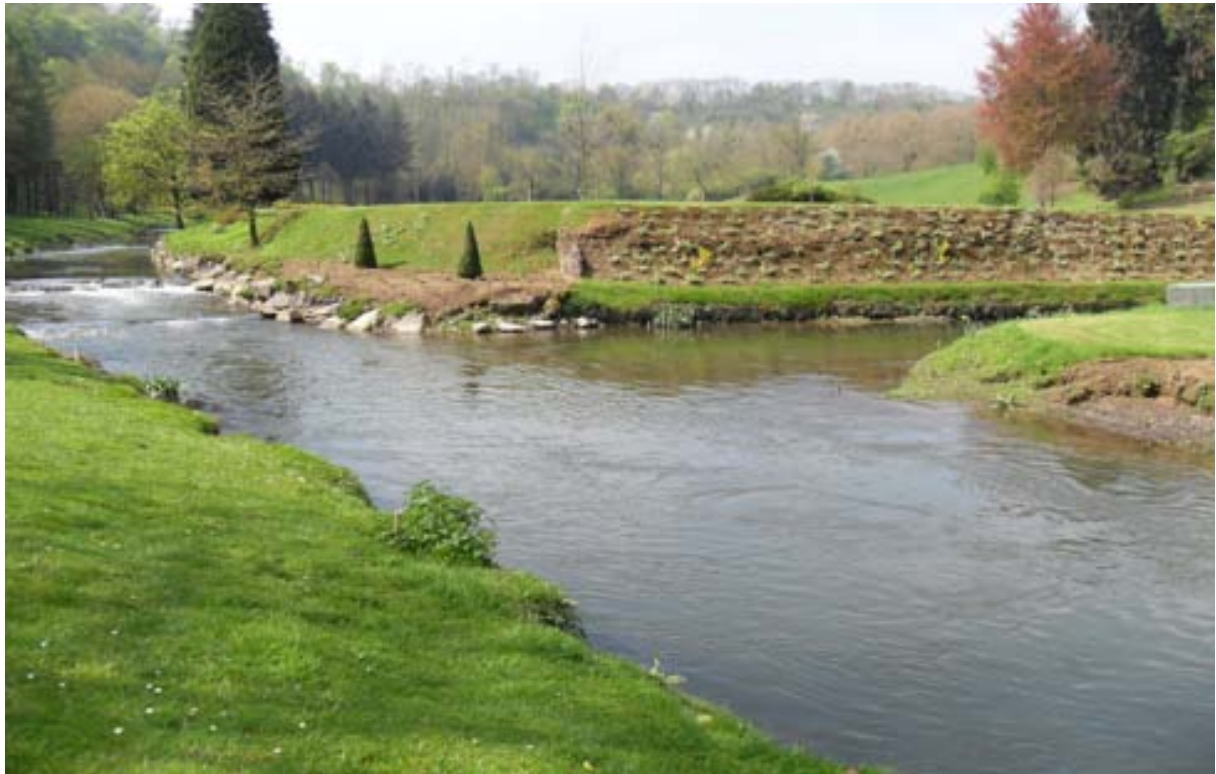
Photo 2: Vue de la zone de confluence entre le canal de fuite de la centrale de Huccorgne et la Méhaigne
